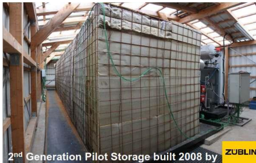
Σχήμα 8.24. Διάταξη αποθήκευσης θερμότητας με βάση το σκυρόδεμα, πηγή: Tamme, 2010
