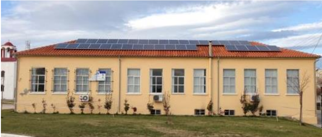
Σχήμα 8.4. Φωτοβολταϊκή εγκατάσταση 10kWp σε δημοτικό κτίριο του Δ. Αλεξανδρούπολης (πηγή: kriton-energy.gr)
