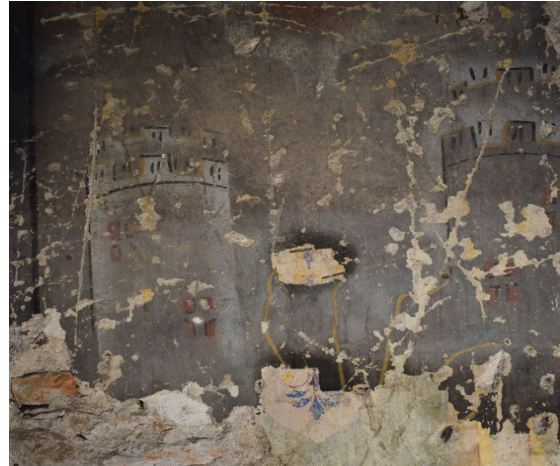
Φωτ. 12: Λεπτομέρεια από τον νεώτερο διάκοσμο
