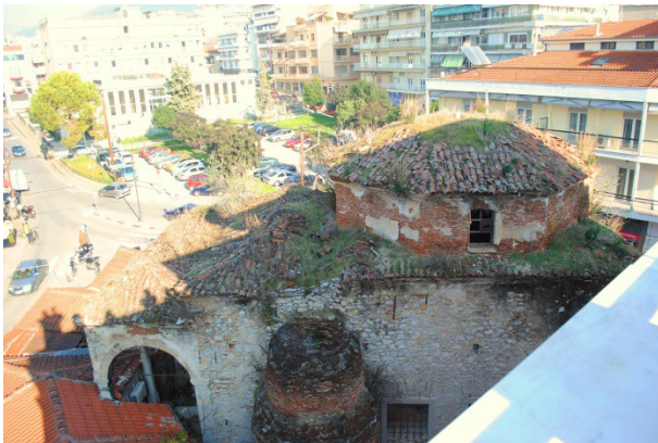
Φωτ. 5: Άποψη της στέγης
