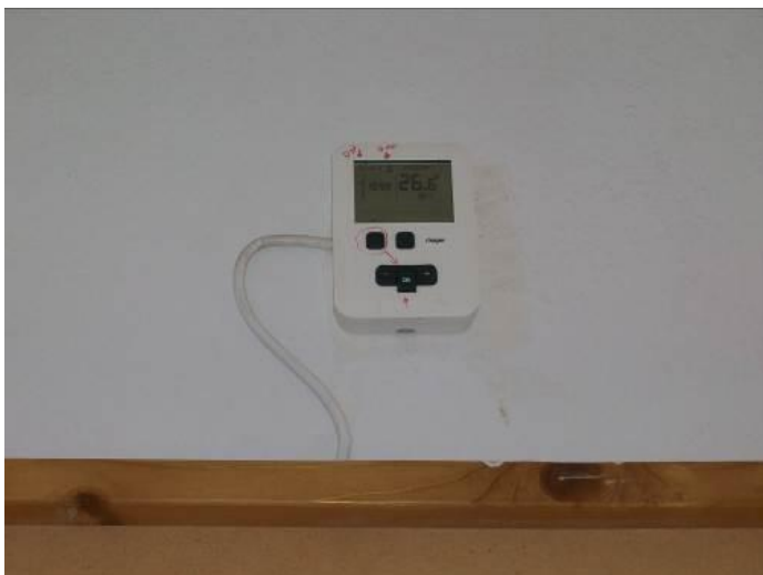
Εικόνα 10: θερμοστάτης χώρου στην ανατολική πτέρυγα.
