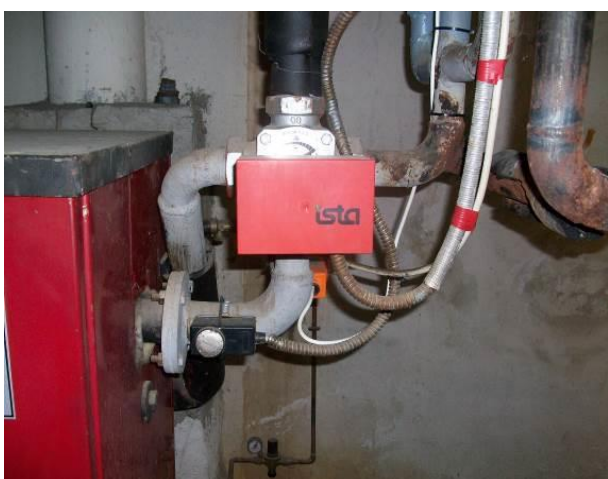
Εικόνα 9: Ανατολικό λεβητοστάσιο σύστημα αντιστάθμισης.
