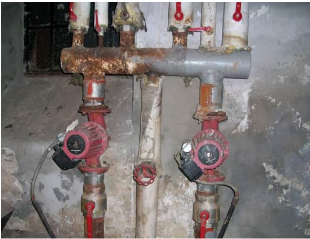
Εικόνα 14: Συλλέκτης προσαγωγής κεντρικού λεβητοστασίου.
