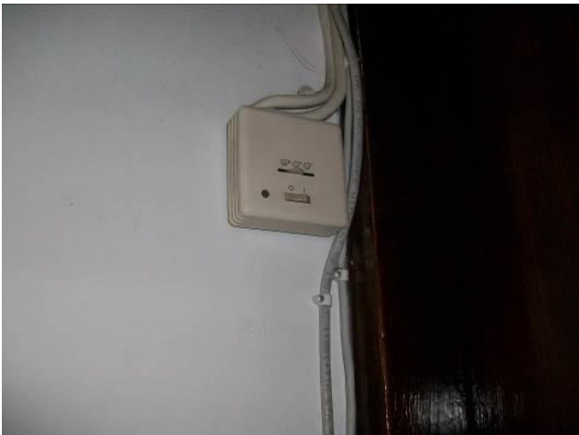
Εικόνα 13: Σύστημα χειρισμού ανεμιστήρων στο αμφιθέατρο.
