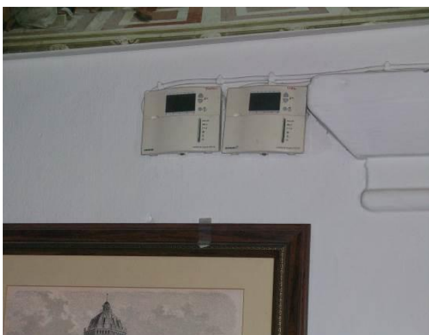
Εικόνα 7: Θερμοστάτες και χρονοδιακόπτης κεντρικού λεβητοστασίου.
