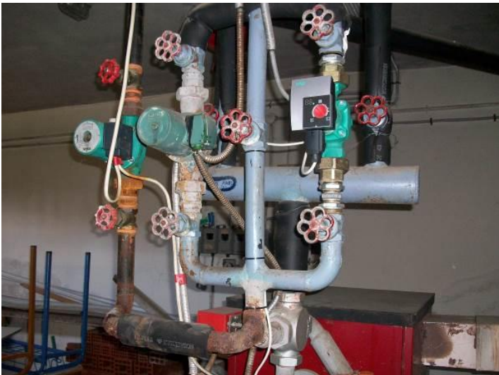
Εικόνα 15: Κυκλοφορητές ανατολικού λεβητοστασίου.
