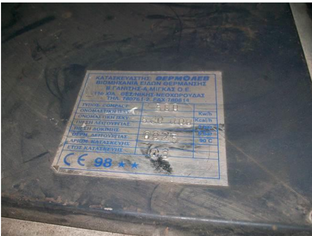
Εικόνα 5: Στοιχεία λεβήτων κεντρικού λεβητοστασίου
