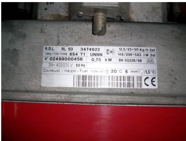
Εικόνα 6: Στοιχεία καυστήρων κεντρικού λεβητοστασίου
