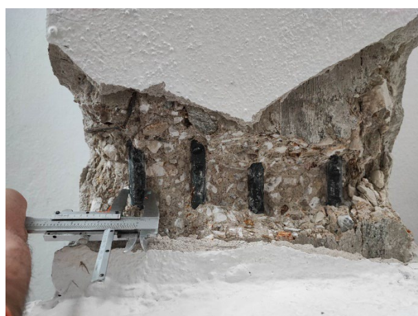
Εικ. 3.12 : Μέτρηση διαμέτρου οπλισμού (οροφή υπογείου)
