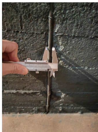
Εικ. 3.10 : Μέτρηση διαμέτρου οπλισμού (οροφή υπογείου)
