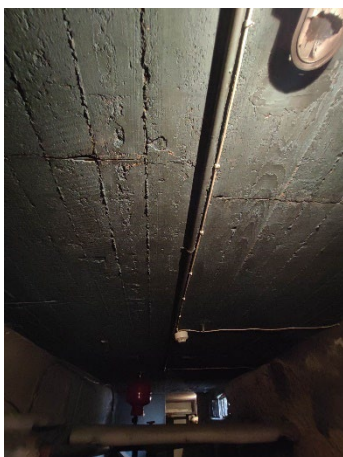
Εικ. 3.9 : Θέση άμεσης διερεύνησης (υπόγειο - λεβητοστάσιο)
