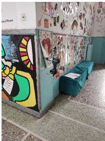
Εικ. 3.7 : Διερεύνηση υλικού δόμησης τοίχου ισογείου
