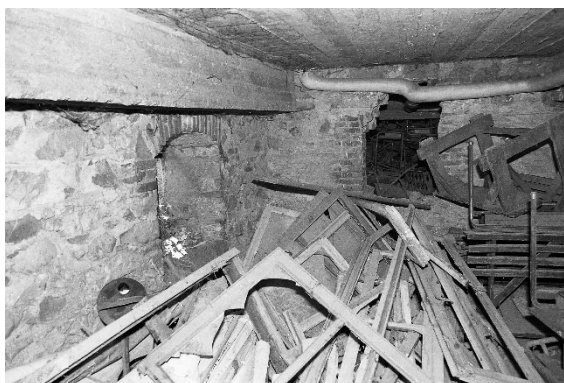
Εικ. 2.4 : Λιθοδομή και πλάκας οροφής ημιυπογείου
